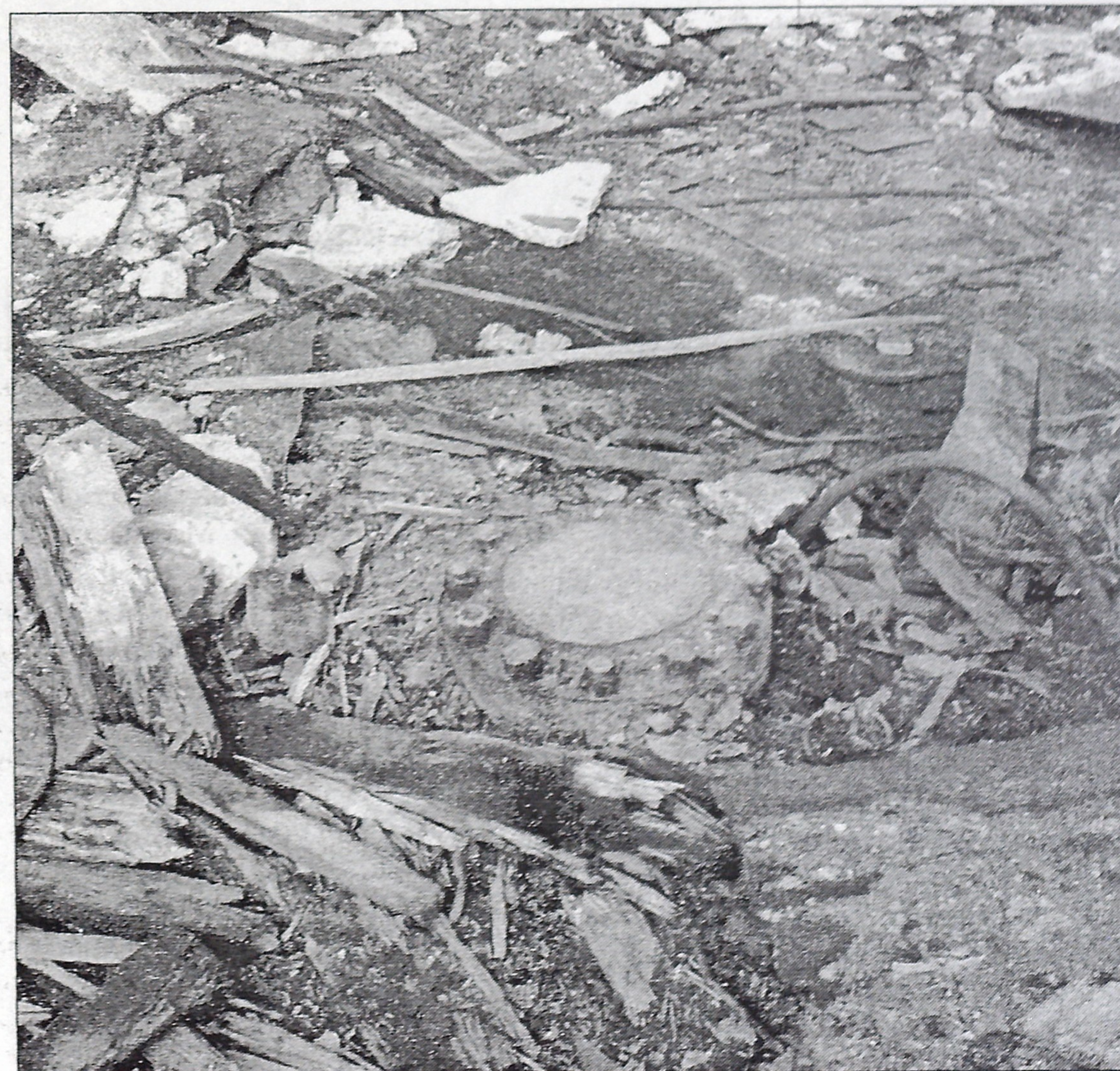
Заваренное отверстие ствола
