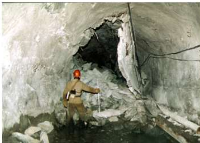
Рис. 3. Разрушение горных выработок рудника «Умбозеро» в результате техногенного землетрясения 17.08.1999 г.
