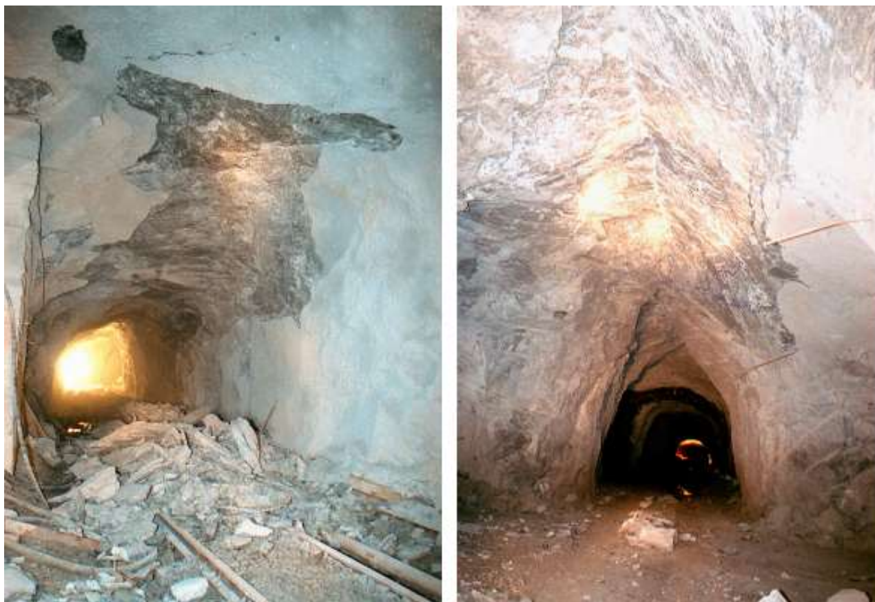
Рис. 2. Разрушение выработок под действие высоких напряжений в массиве ГП
