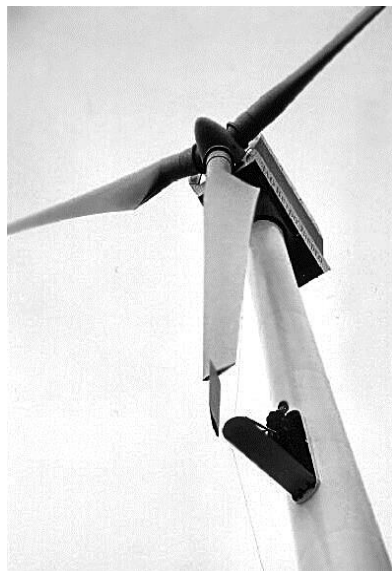
Рис. 3. Осмотр аэродинамической тормозной системы ветроустановки (высота 30 м)
