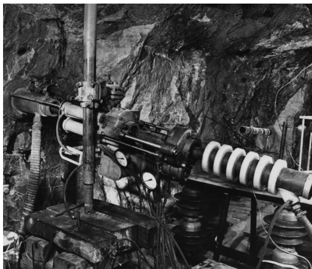
Рис. 15. Установка электроимпульсного бурения, Кировский рудник ОАО «Апатит»
