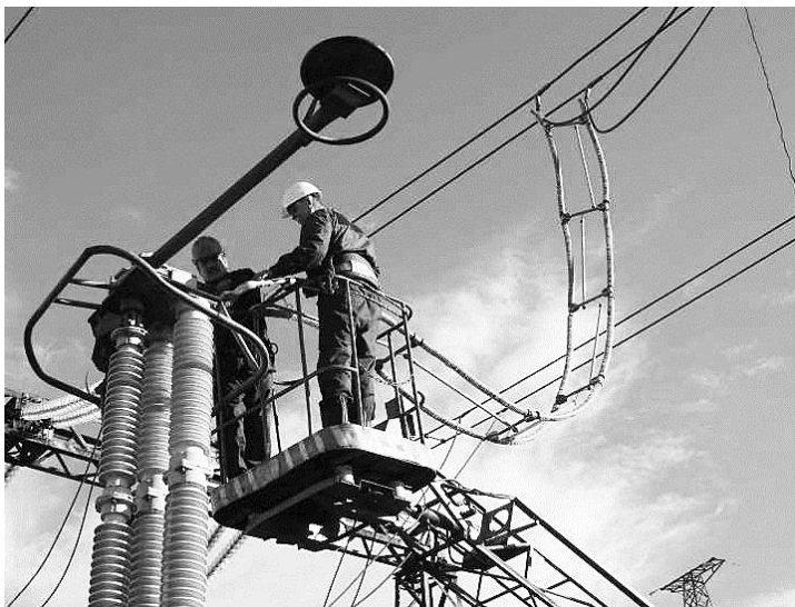
Рис. 4. Монтаж устройства активно-индуктивной защиты от внутренних перенапряжений на подстанции 330 кВ вблизи г. Апатиты
