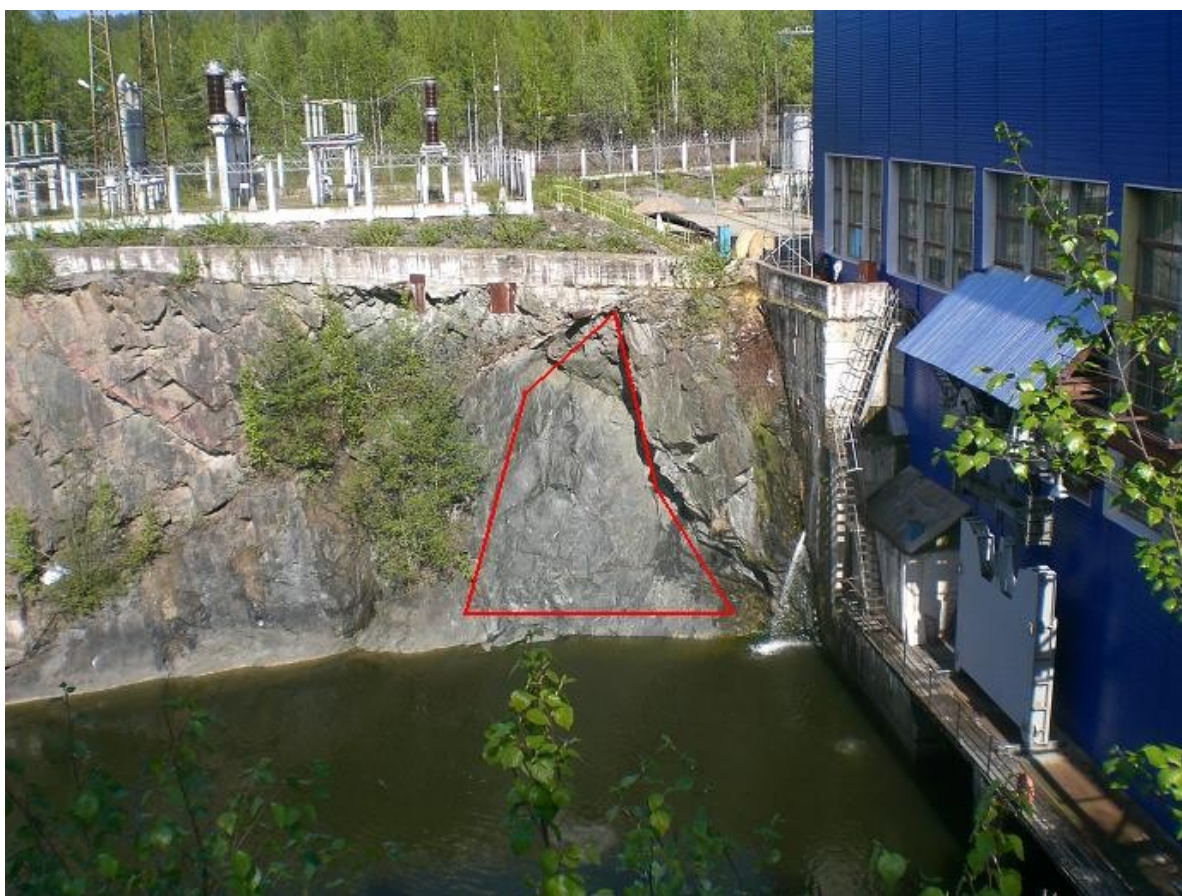
Рис. 2. Правый берег канала с зоной вывала 50\text{--}60 м 3
