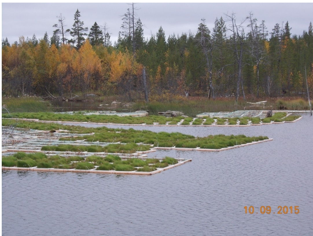
Рис. 6. Плавающее биоплато на пруду-отстойнике Кировогорского карьера, АО «Олкон» [49]
