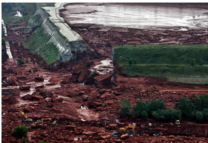
Рис. 1. Авария на хвостохранилище в Колонтаре (Венгрия) [по 1]
