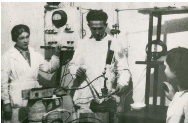
Рис. Разработка технологии получения плавяных магниевых фосфатов в Геохимической лаборатории Кольской базы АН СССР в п. Кукисвумчорр (в центре – Б.Н.Мелентьев, слева – З.М.Гилева, справа – З.И.Корнильева (Горощенко) (Фото из личного архива Л.Б.Мелентьева)
