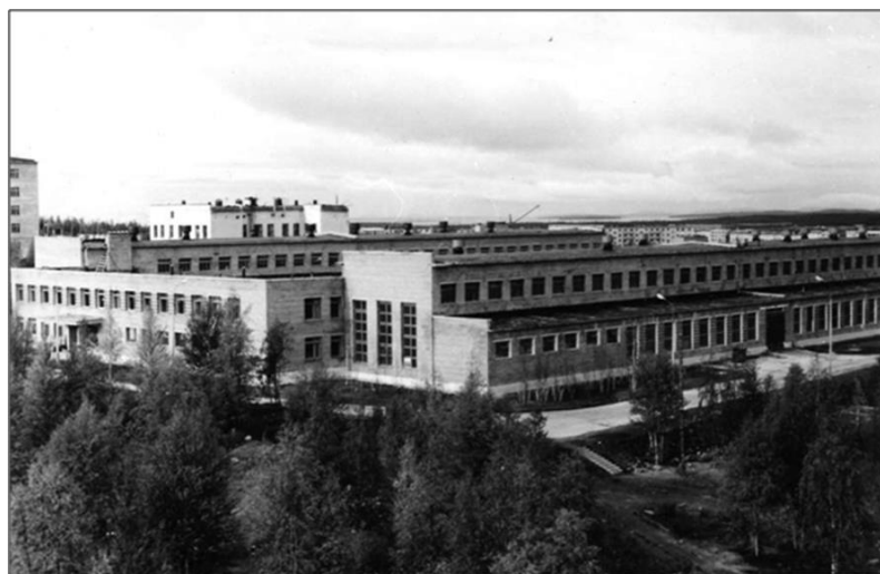
Рис. 3. Общий вид корпуса опытно-промышленной обогатительной установки
