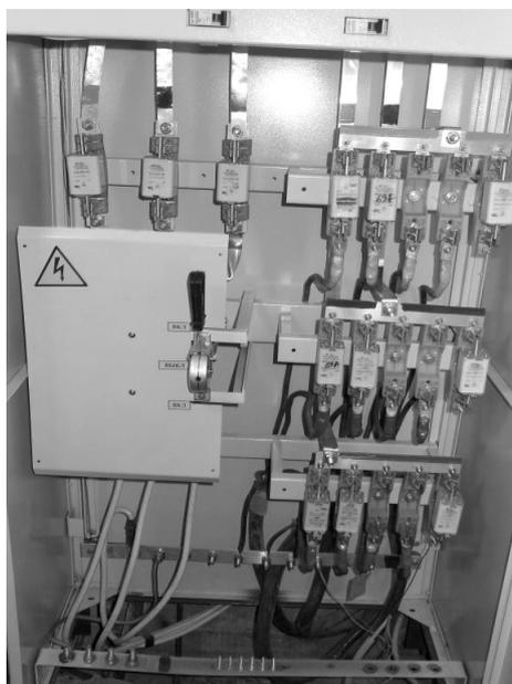
Рис.2. Распределительное устройство 0.4 кВ
