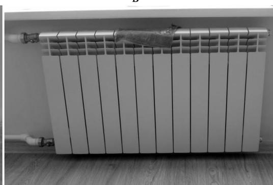
Рис.7. Радиаторы отопления: а – трубные; б – чугунные; в – алюминиевые
