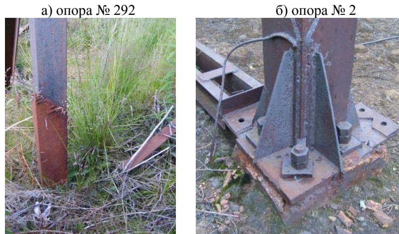
Рис.1. Оседание фундамента опоры линии (а) и отсутствие стяжки между ногами опоры (б) (Л-153/154)
