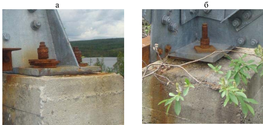
Рис.5. Неплотное прилегание пят опоры № 171 Л-398 к подножникам с образованием зазора между пятой и подножником: в одном случае – около 1 см (а), в другом случае – порядка 4 см (б)
