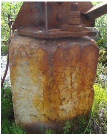
Рис.3. Сколы бетона, раковины и трещины, неплотное прилегание одной из пят к подножнику с образованием щели шириной 1-4 см на опоре № 8 линии Л-171/172
