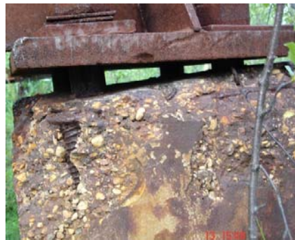
Рис.6. Дефект установки опоры № 77 линии Л-400 на подножник
