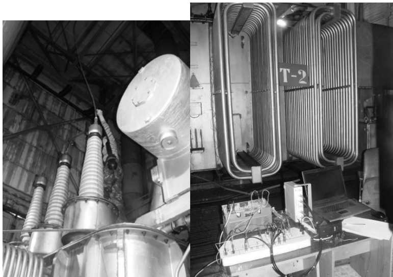
Рис.2. Подготовка ГИК для обследования трансформатора ТДН-10000
