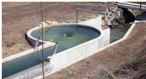
Рис.3. Гравитационно-водоворотная мини-ГЭС
