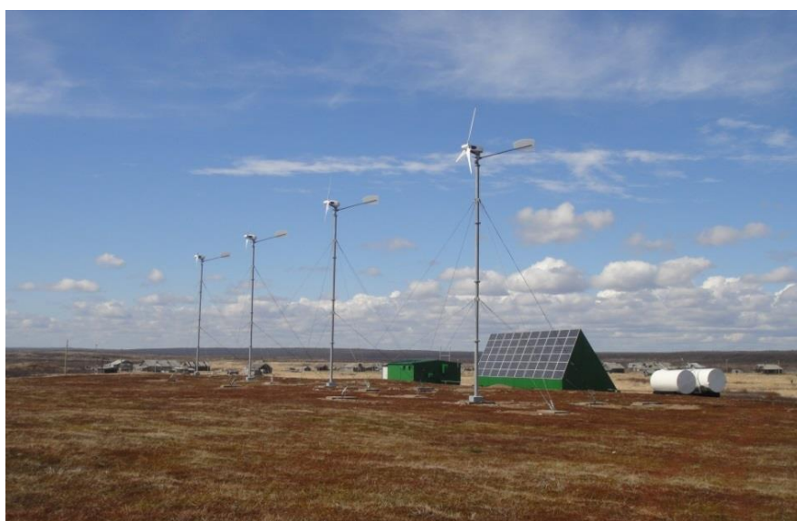
Рис. 9. Ветро-солнечно-дизельная энергоустановка в с. Пялица
