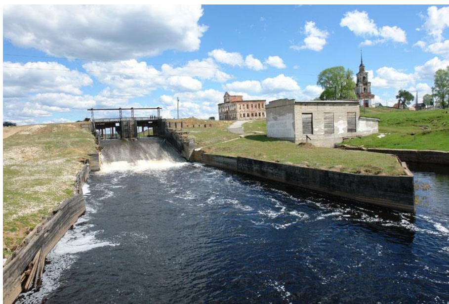
Рис. 5. Кажимская малой ГЭС
